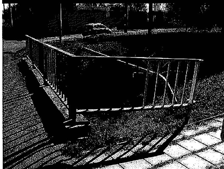
Deformace zábradlí a koroze
